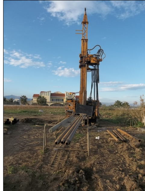
Foto 1 e Foto 2 – Sonda CMV MK 900 gommata posizionata sul sondaggio S 1 e S 2
