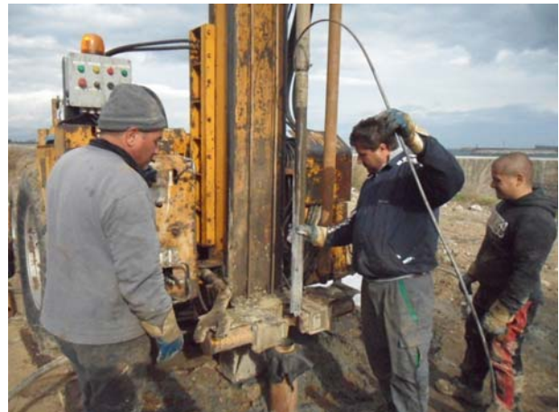
Foto 4 – Estrazione della sonda
