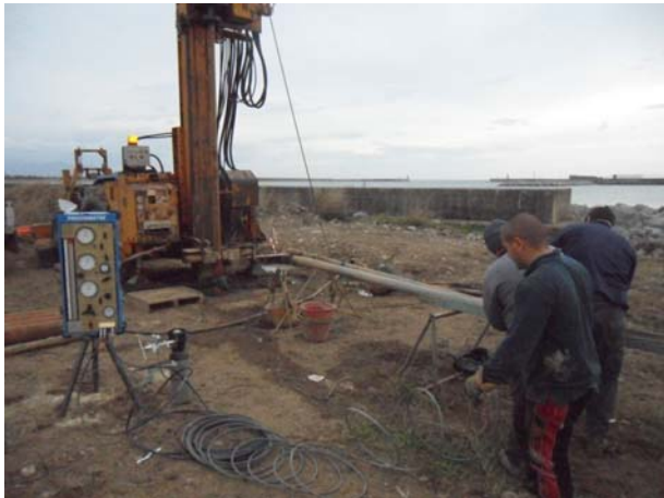
Foto 1 – Preparazione del cantiere
