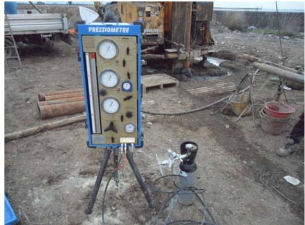
Foto 2 – Unità di controllo (CPV)
